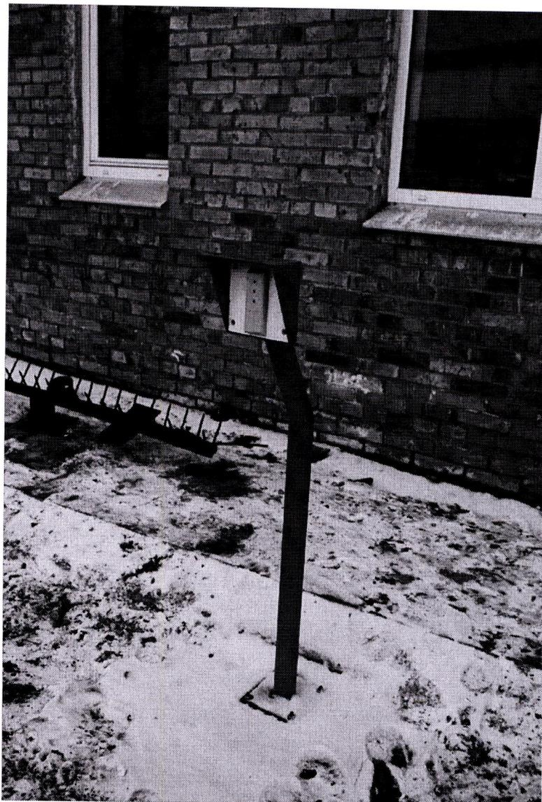
Приложение 4. Считыватель пластиковых пропусков на автопроходной
